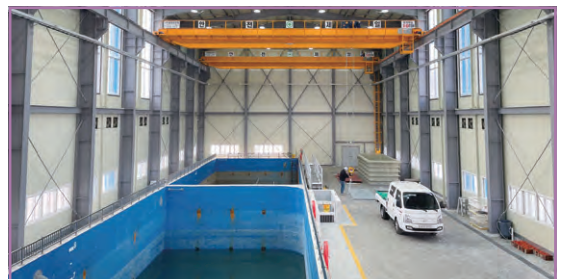
대형수조(시험수조, 배양수조) 및 크레인(2EA) Large water tank(test&culture tank) & Crane(2EA)
